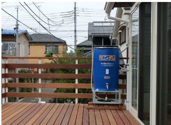
屋根の雨水を有効活用「雨水タンク 200L」
