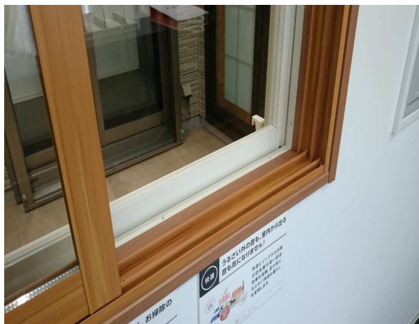
既存窓の断熱対策「既存窓の内側に樹脂内窓」
