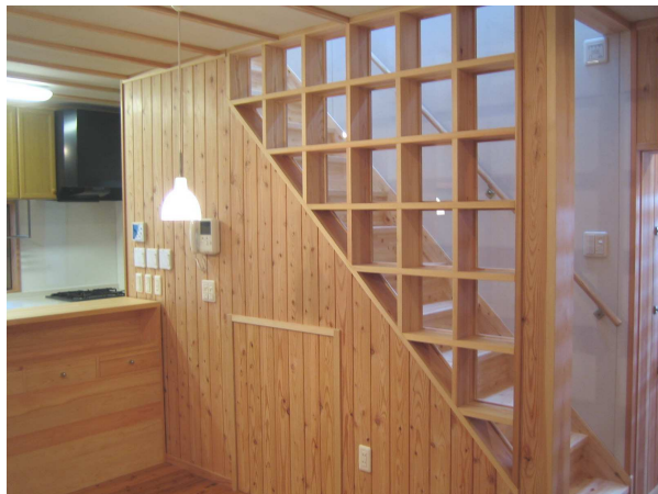
耐震改修「階段位置を変更してワンルーム」
